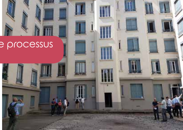
La visite technique de la Cité Mignot a permis aux représentants des trois groupements d'entreprises sélectionnés pour l'appel à projet de mesurer l'intérêt du futur chantier.
